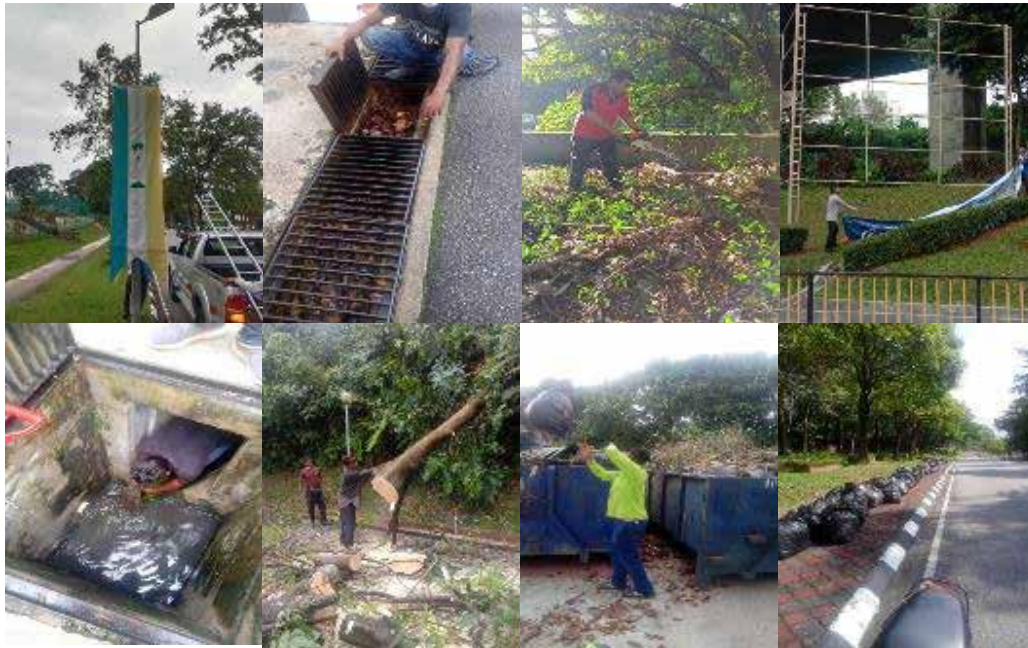
Gambar 6.2 Aktiviti kerja penyelenggaraan lanskap
