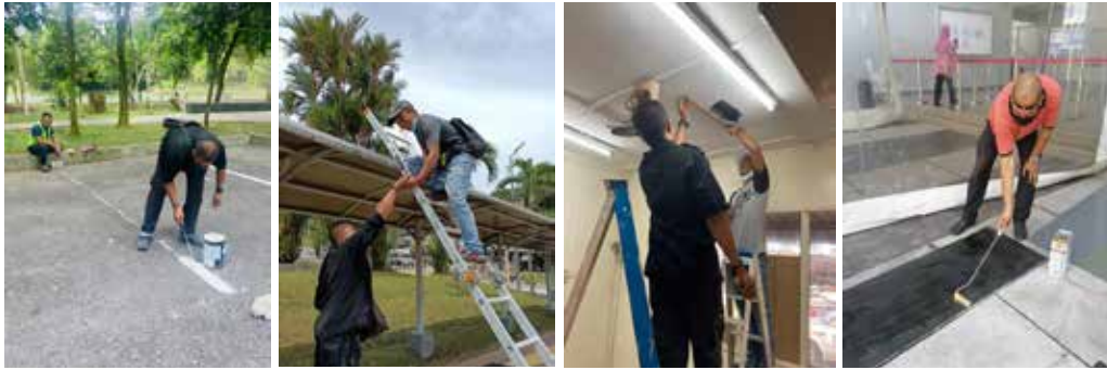
Gambar 7.1.5 Antara kerja-kerja penyelenggaraan yang dijalankan secara in-house .
