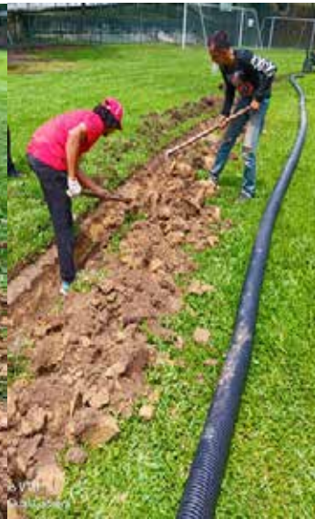
Pemasangan Saluran Air di Padang B (Drainage System)
